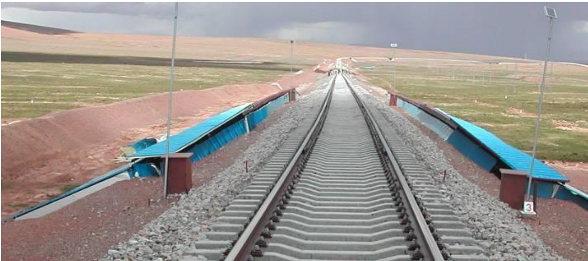
Рис. 2 – Солнцезащитные навесы на откосах насыпи Цинхай-Тибетской железной дороги
