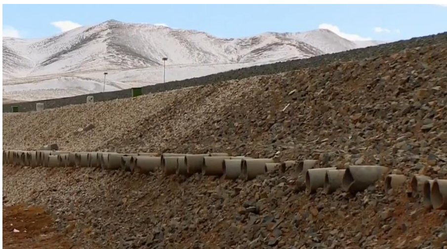
Рис. 1 – Охлаждение насыпи при помощи сквозных труб
