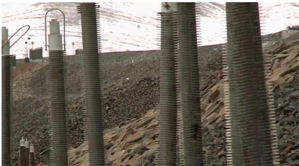
Рис. 3 - Термосифоны на откосах насыпи Цинхай-Тибетской железной дороги
