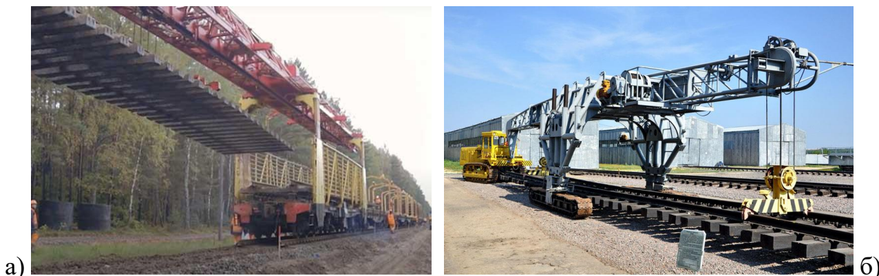
Рисунок 1 – Укладчики железнодорожного пути а) укладочный кран УК-25/9-18; б) путеукладчик ПБ-3М
