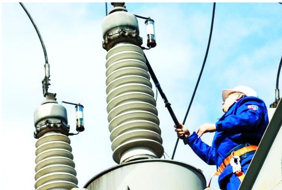
Рисунок 2 – Проведение контроля состояния вводов трансформатора
