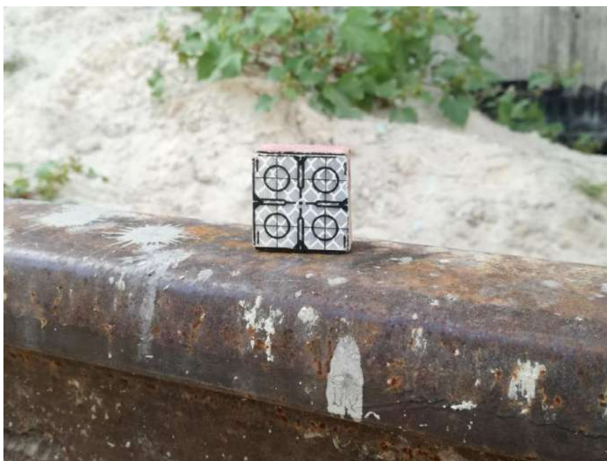
Рисунок 3 – Установка марки на ось рельса подкранового пути
